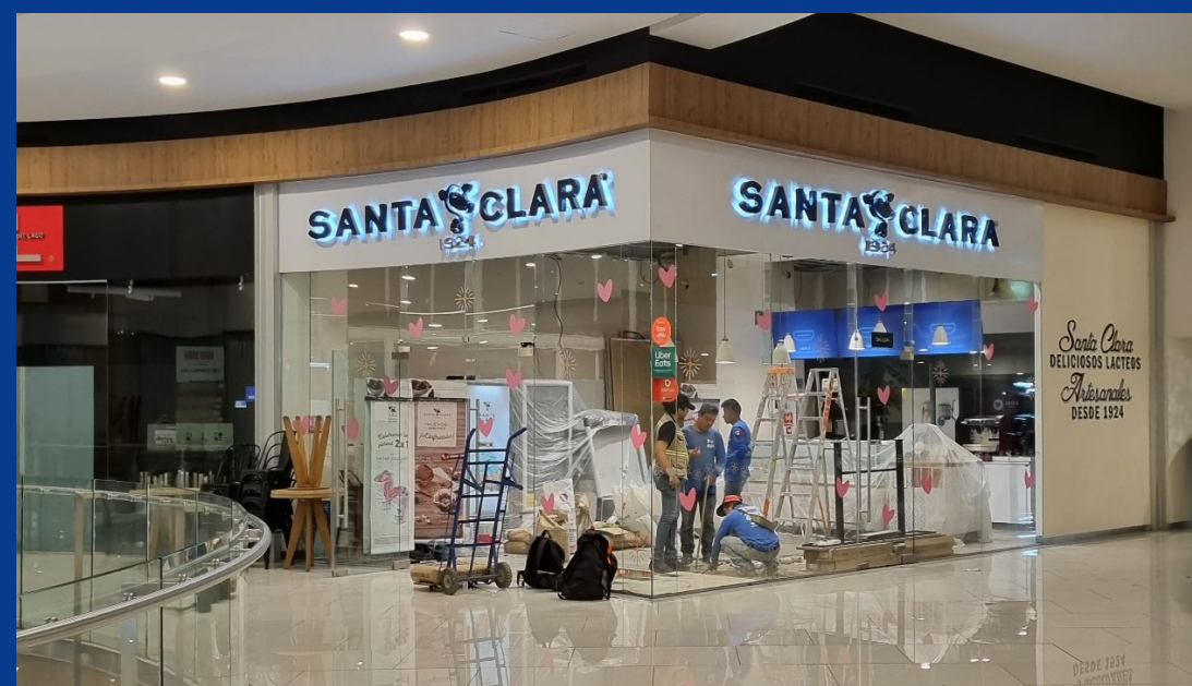
EJECUCIÓN EN CAMPO
